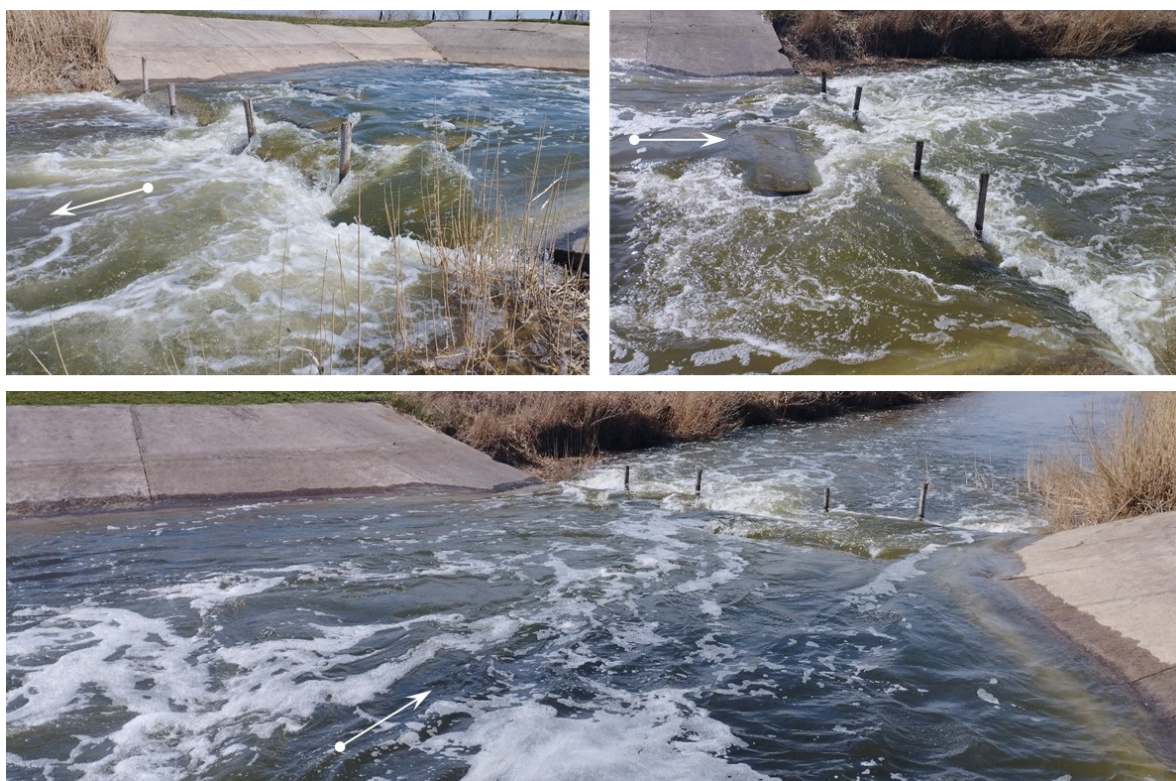
Рисунок 17 – Виды течений водного потока на выходе из головного регулятора в тракт рыбоходного канала № 1 (автор фото А. В. Шевченко)
