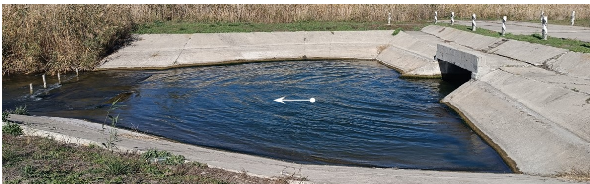
Рисунок 15 – Вид головного регулятора рыбоходного канала № 1 (автор фото О. А. Баев)
