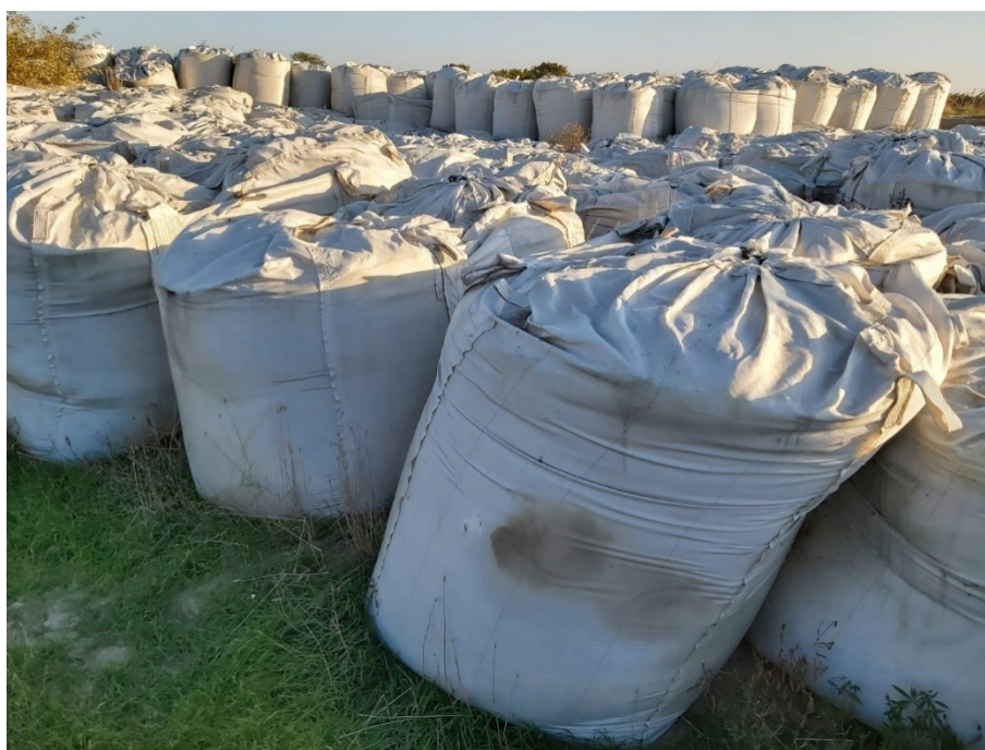
Рисунок 2 – Складирование геосинтетических мешков, наполненных песком (фото А. А. Ткачева)
